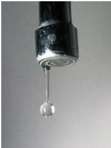
Abbildung: Demonstration von Verkalkung am Beispiel eines Wasserhahnes.
